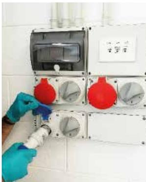
Elektrischer Anschluss für den Drehstrommotor (5-poliger Stecker)
