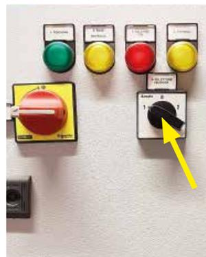
Phasenumkehrschalter nur in der Ausführung mit Partikelzähler ICM2.0 Fig.7
