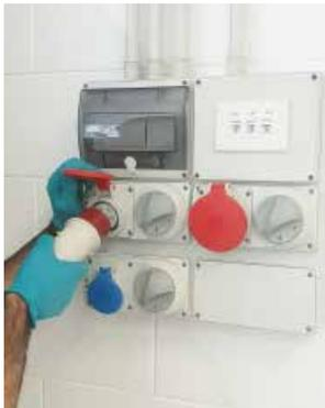
Elektrischer Anschluss für den Drehstrommotor (5-poliger Stecker) Fig.6
