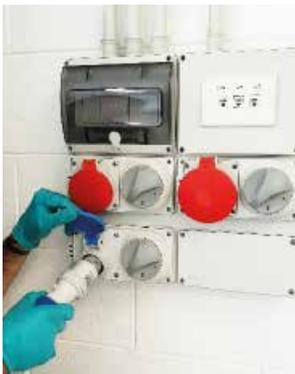
Elektrischer Anschluss für den Drehstrommotor (5-poliger Stecker)
