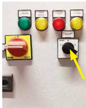
Fig.7 Phasenumkehrschalter nur in der Ausführung mit Partikelzähler ICM2.0
