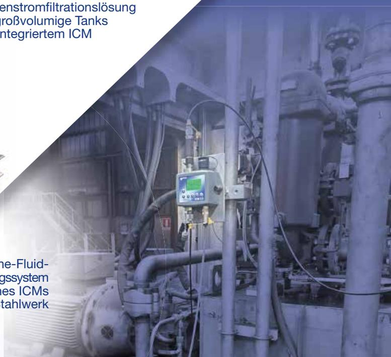
24/7-Inline-Fluid-Überwachungssystem auf Basis eines ICMs in einem Stahlwerk
